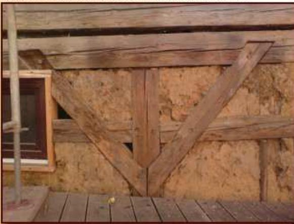
Mit sonst in Sachsen unbekanntem Gefügen tritt das Haus Pfaffenberg 15 in anderer Art hinzu. Von außen heute unscheinbar, verbirgt es hinter der Fassade einen erdgeschossigen Fachwerkbau mit einem zweilagigen Blockkranz auf der Balkenlage, indessen oberste Lage die Sparren in Ausnehmungen eingelegt und mit einem Holznagel befestigt worden sind.
