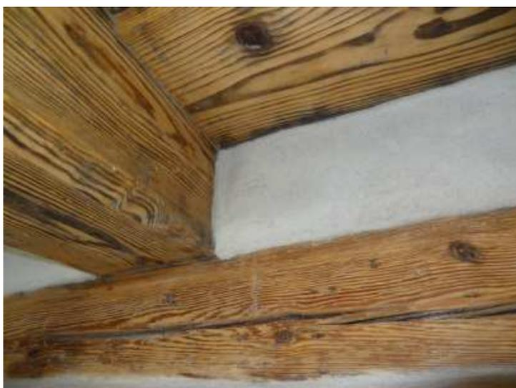
Lagerbalken mit Deckenbalken und Einschubbrettern und den Schiffchen am Balken
