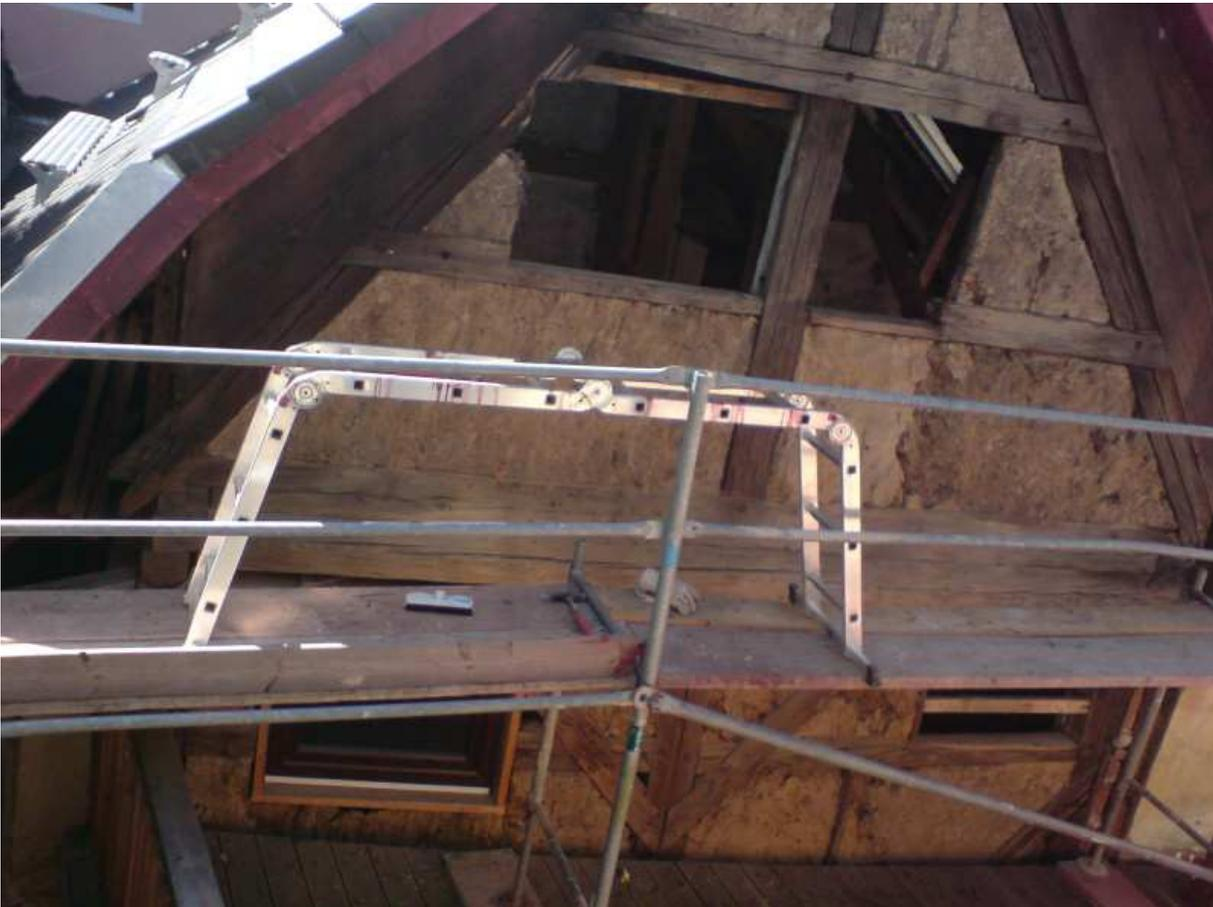
Der erdgeschossige [Fachwerkbau](#) (siehe [Fachwerk](#)) ist auf Eichenschwellen aufgeständert. Diese sind auf Lagersteine zum Schutz gegen Feuchtigkeit aufgelegt. Das [Fachwerk](#) ist mit Brust- und Halsriegel zweiriegelig ausgeführt. Diese sind mit Zapfen und Aussparungen in den Ständern verbunden. Hinzu kommen Kopf und Fußstrebe. Die Streben dienen der Aussteifung der Fachwerkkonstruktion und sind in die Ständer geblattet. Fußstrebe und unter Riegel sind durch Verschränkung verbunden
