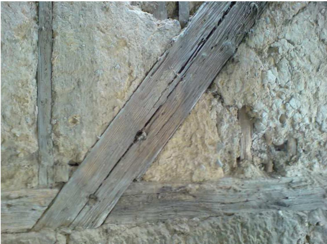
Fußstrebe des Umgebindehaus mit Gefach im Fachwerk und Auflager aus Mauerwerkstein
