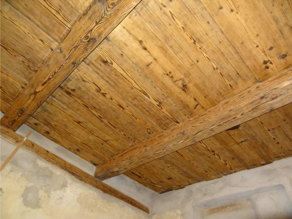
Balkendecke oder Holzbalkendecke als Original erhalten von 1587 und sichtbar. Farbe von Jahrhunderten und Ruß wurden entfernt. Balken mit sogenannten Schiffchen. Holzbalkendecke mit Einschubrettern.
