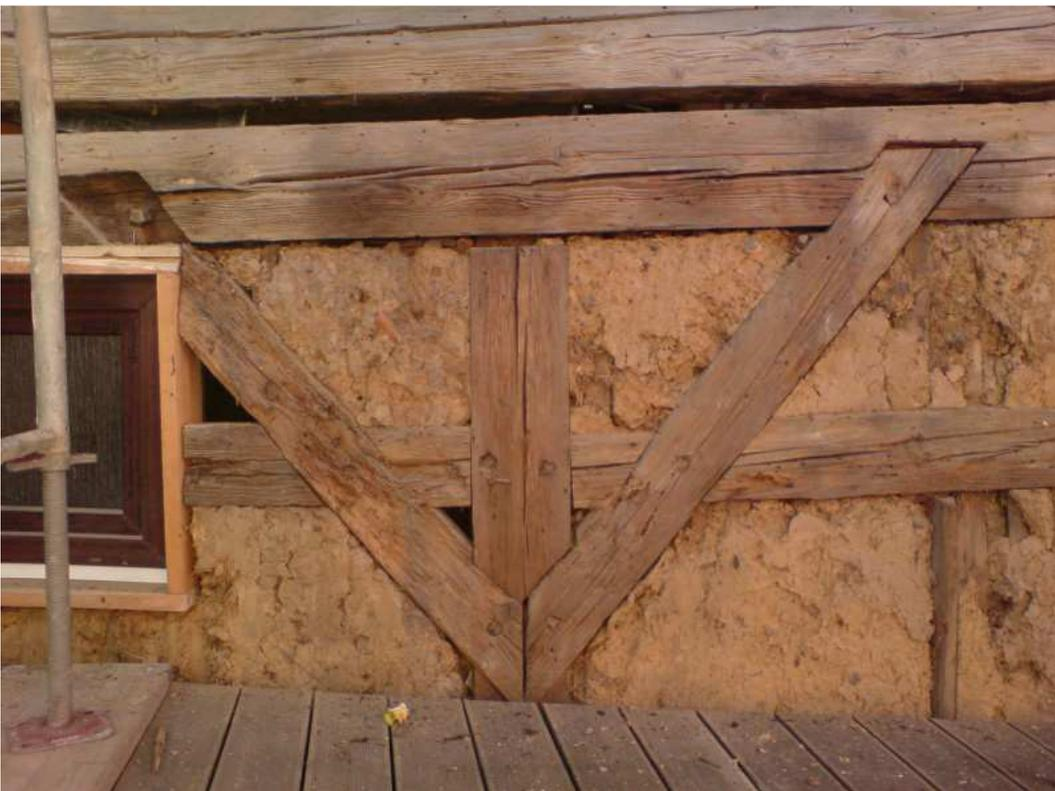
Mittelständer mit Kopfstreben geblattet mit obersten Riegel des zweiriegligen Fachwerks
