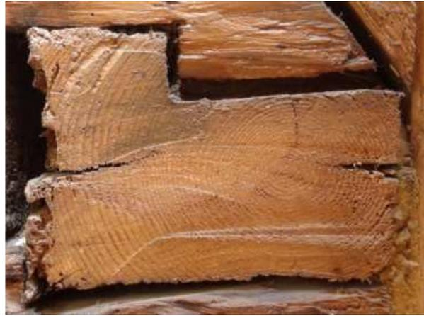
Verzahnung der Balken des zweilagigen Blockkranz Verzinkung am Sparren und inneren Giebel.
